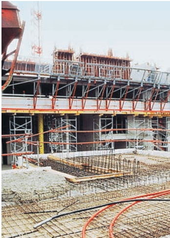
Mise en œuvre en fond de coffrage
