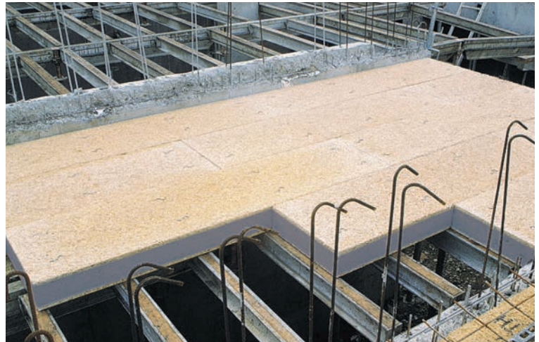
Pose de panneaux agrafés sur coffrage industrialisé
