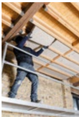
Mise en place entre chevrons.
