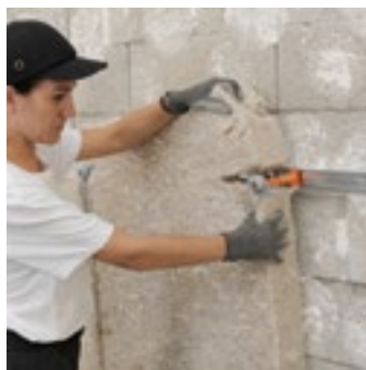
ThermaSoft® natura de par sa flexibilité, s'adapte facilement à l'ossature métallique et aux appuis intermédiaires.
