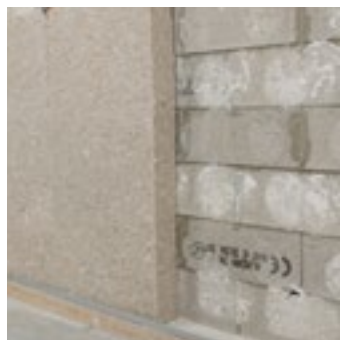
Pose directe de l'isolant contre la paroi extérieure.
