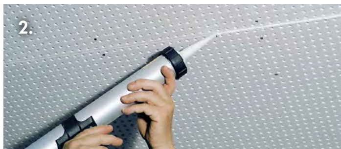
2. Réaliser les joints avec l'enduit Jet Filler à l'aide du pistolet extrudeur pneumatique.
