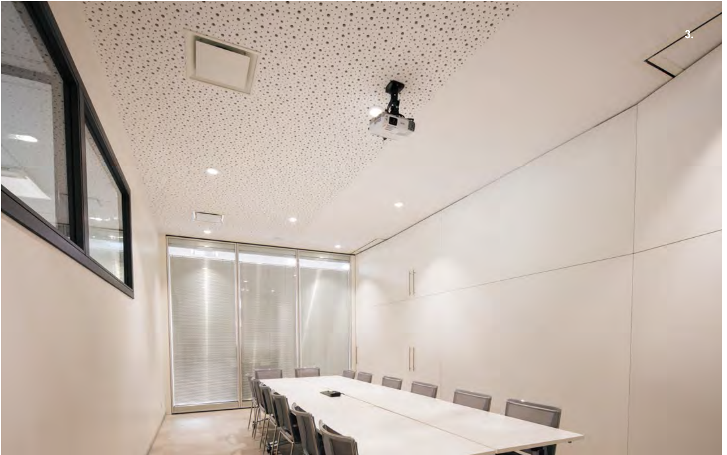
3. Caisse d'Épargne Alsace, Colmar (68) - salle de réunion - Knauf Delta Aléatoire - Architecte : Korus
