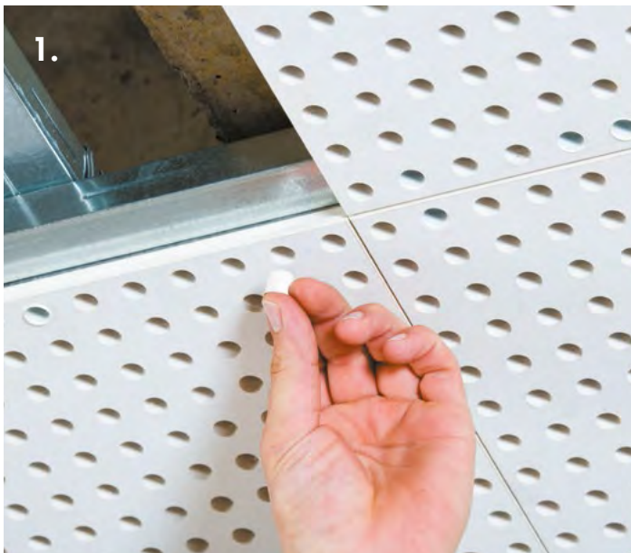
1. Mise en place du capuchon
