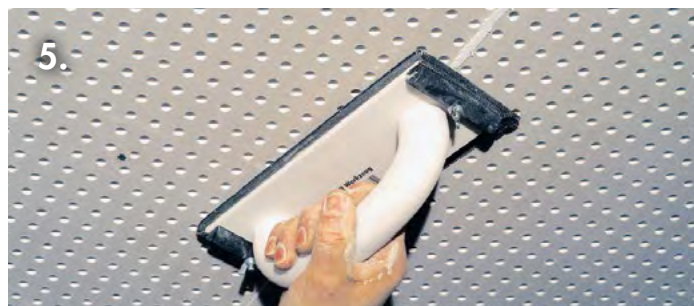
5. Après 24 heures, poncer légèrement avec la trame à poncer
