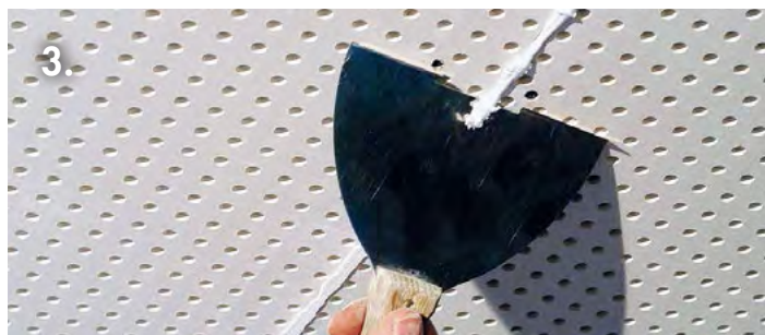
3. Couper l'excédent de matière en laissant une épaisseur de 1 mm.
