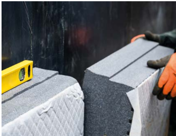
Emboîtement entre les feuillures des panneaux Knauf Perimaxx ULTRA, à joints serrés
