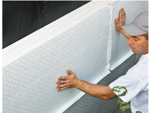
Emboîtement et serrage des panneaux de Knauf Perimaxx Resist entre eux
