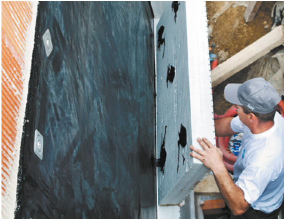
Collage des panneaux de Knauf Perimaxx Resist sur le support, de bas en haut
