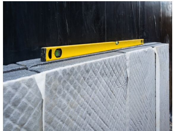
Collage des panneaux Knauf Perimaxx ULTRA sur le revêtement d'étanchéité, à partir du sol
