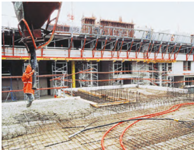
Mise en œuvre en fond de coffrage
