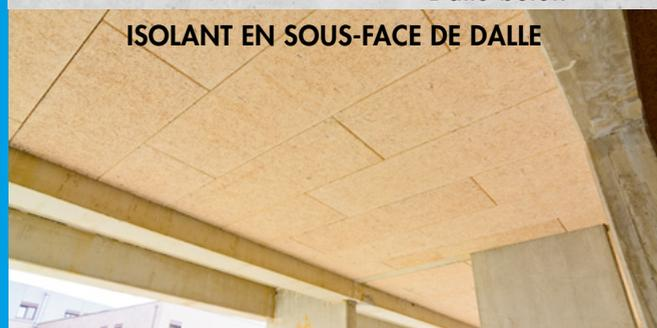
ISOLANT EN SOUS-FACE DE DALLE
