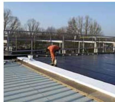
Panneaux en polystyrène expansé, polyuréthane ou polystyrène extrudé
