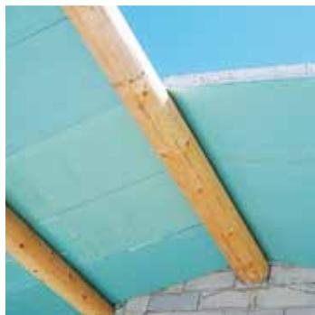
Panneaux sandwich et panneaux à base d'isolant
