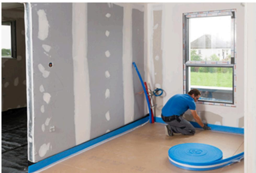
*La bande de rive Knauf Perimousse Universel est compatible avec toutes les épaisseurs d'isolants et tous les types de chapes hydrauliques. [©Knauf]*
