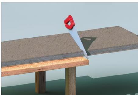
Lorsque des réservations sont nécessaires, on prendra soin de protéger les tranches du panneau de polystyrène par un panneau de Fibralth ép. 25 mm minimum.
