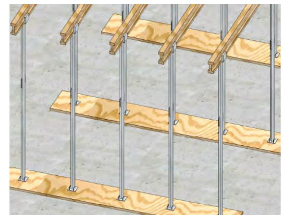
Fig. 4 : Mise à niveau des poutrelles
