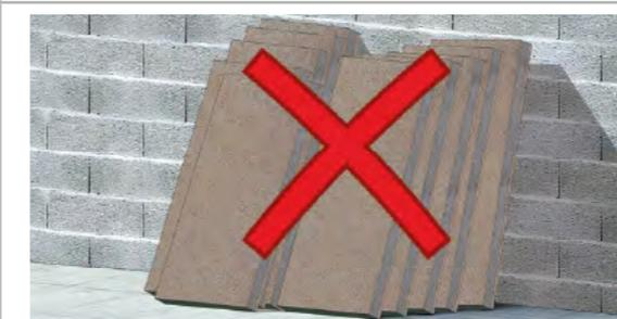
Fig. 17 : Stockage des panneaux à plat
