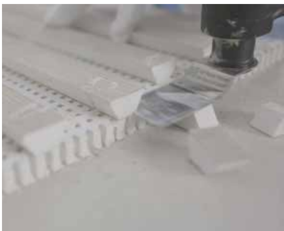
Fig. 8 : Pour obtenir un bon raccordement des dalles sur les bords des murs, couper les lattes selon la cote souhaitée. Poser les dalles sur les cornières de rive.
