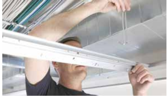
Fig. 5 : Installer le profilé primaire dans le même sens que le sens voulu pour les bandes de plâtre du Rold12. Premier profilé à 200 mm max. du mur. Entraxe max. entre deux profilés 1200 mm. Pour prolonger la structure, visser les profilés entre eux.
