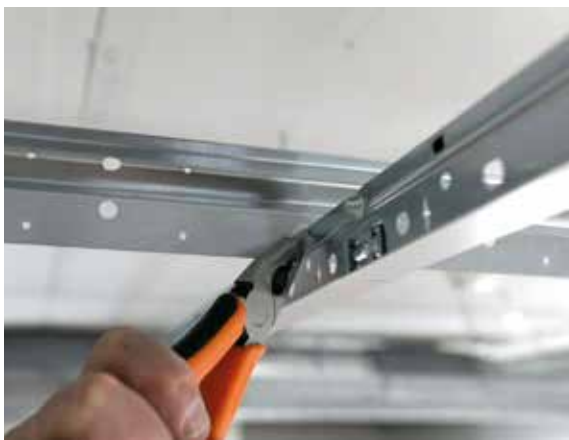
Fig. 6 : Utiliser une pince pour ouvrir les fentes prédécoupées des profilés primaires, insérer les rails T24 puis les refermer. Pour prolonger la structure, clipper les rails entre eux.
