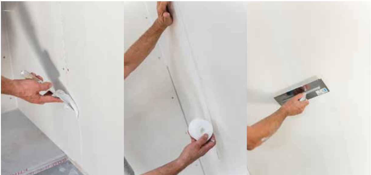
Fig. 4 - Enduisage et mise en place de la bande à joint Knauf HydroProof® avec l'enduit prêt à l'emploi Knauf Proplak® HydroProof® : facile à mettre en œuvre, pour un rendu très blanc et une finition parfaite.
