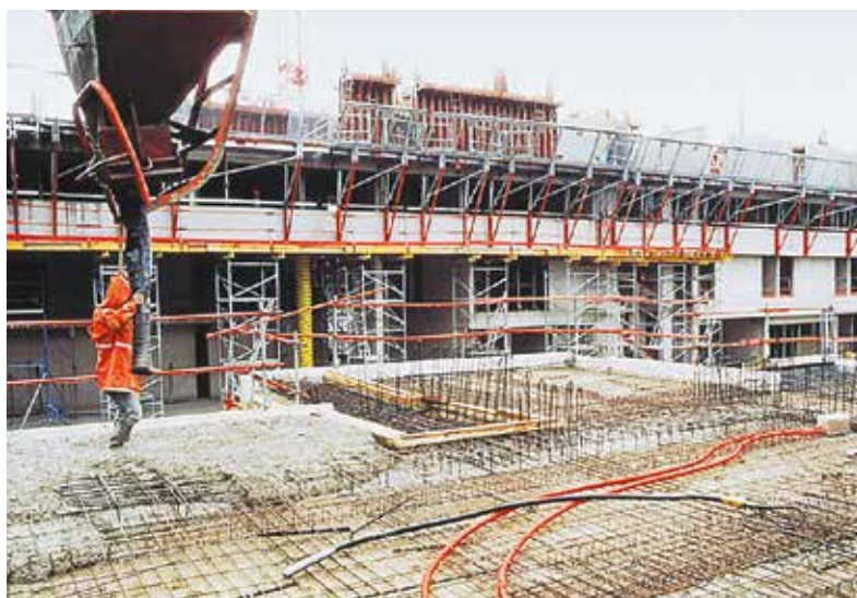
Mise en œuvre en fond de coffrage
