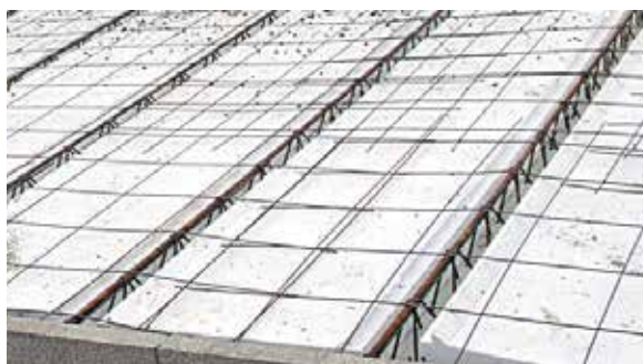
Pose de Knauf Treillis Therm Coffrant traditionnelle
