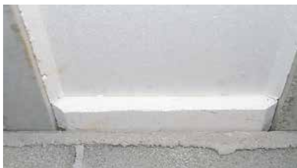
Pose de Knauf Treillis Therm Coffrant about
