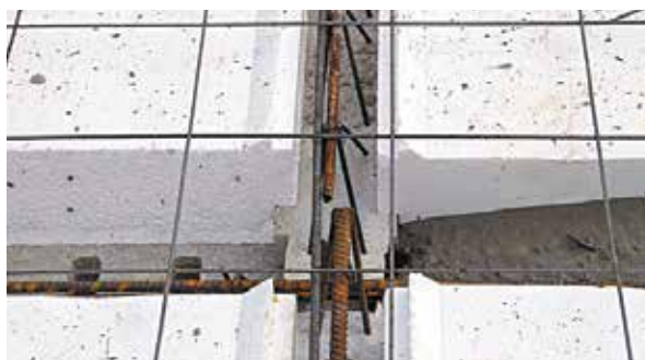
Pose de Knauf Treillis Therm Coffrant retourné sur mur de refend
