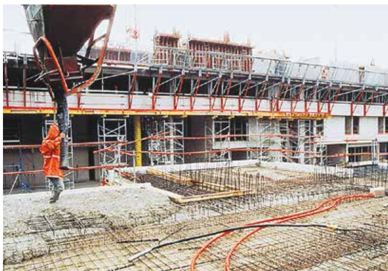
Mise en œuvre en fond de coffrage
