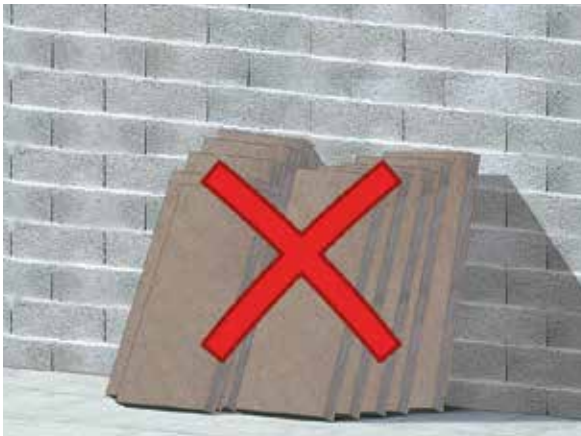
Fig. 17 : Stockage des panneaux à plat
