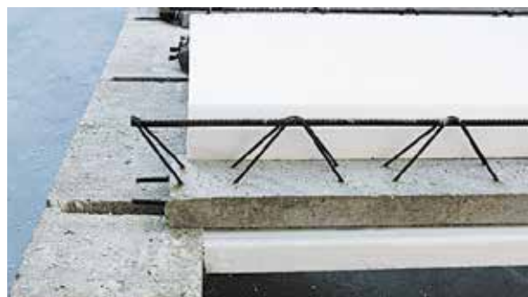
Fig. 2 : vue de la poutrelle sur l'entrevous
