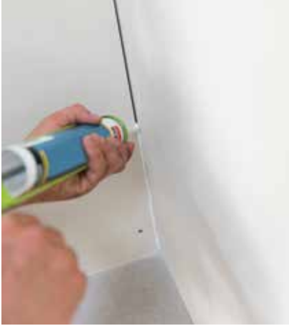
Fig. 3 - Traitement des cueillies, des angles rentrants et des points singuliers à l'aide d'un mastic sanitaire label SNJF
