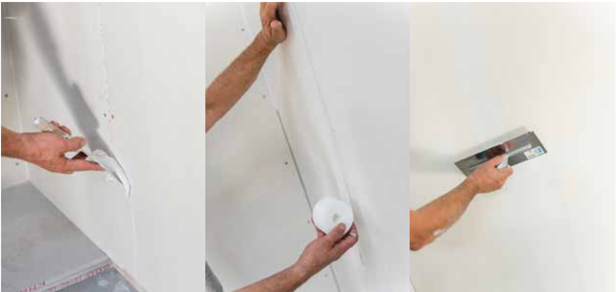
Fig. 4 - Enduisage et mise en place de la bande à joint Knauf HydroProof® avec l'enduit prêt à l'emploi Knauf Proplak® HydroProof® : facile à mettre en œuvre, pour un rendu très blanc et une finition parfaite.
