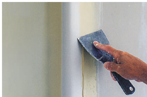
Lissage de l'enduit après pose de la bande Ultrabull (angle arrondi)
