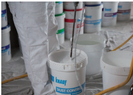
Enduit Knauf Propaint® Dust Control. Malaxage avec la pale Knauf et dilution possible en fonction de vos besoins
