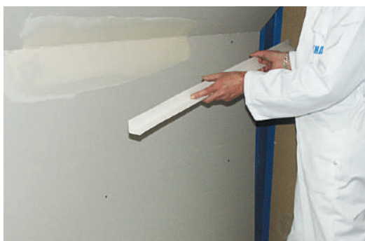
Pose de la bande Ultraflex (angle rentrant)
