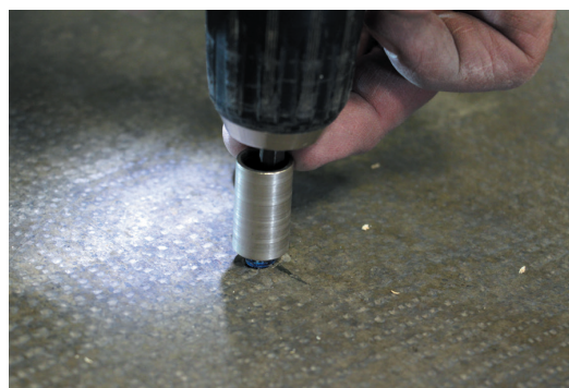
10. Visser l'embout au sol. L'embout déco sol est constitué de 2 parties (2) La première se fixe au sol
