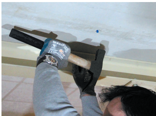
2. Mise en place des 2 chevilles au plafond. Choisir la qualité de la cheville selon le support et le poids du panneaux (voir étape 7)
