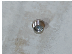
3. L'embout déco plafond est constitué de 2 parties : la première se fixe au support. Choisir le type de vis en fonction du support.
