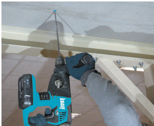
1. Repérage des 2 points de fixation au plafond.
