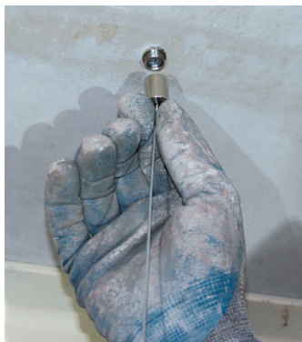
5. Visser la deuxième partie sur la première afin de bloquer le câble en partie haute. Répéter les opérations de 1 à 5 pour fixer le deuxième point de fixation au plafond.
