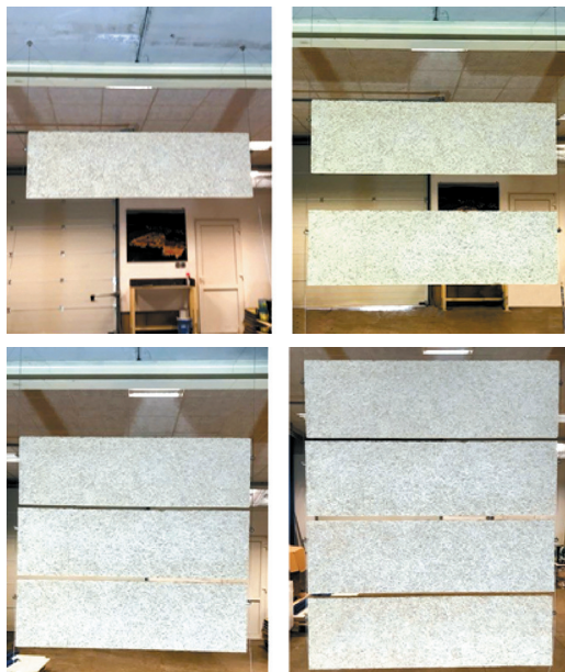
7. Mise en place du nombre de panneaux souhaités sur les câbles.
