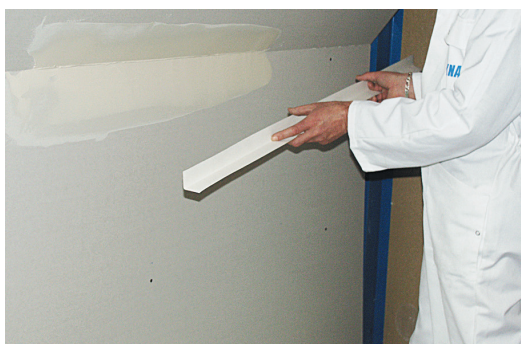
Pose de la bande Ultraflex (angle rentrant)
