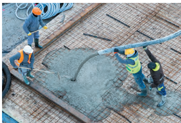
Coulage du béton
