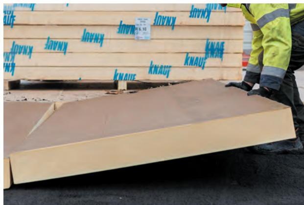
Mise en œuvre à joints serrés des panneaux Knauf Thane Dallage
