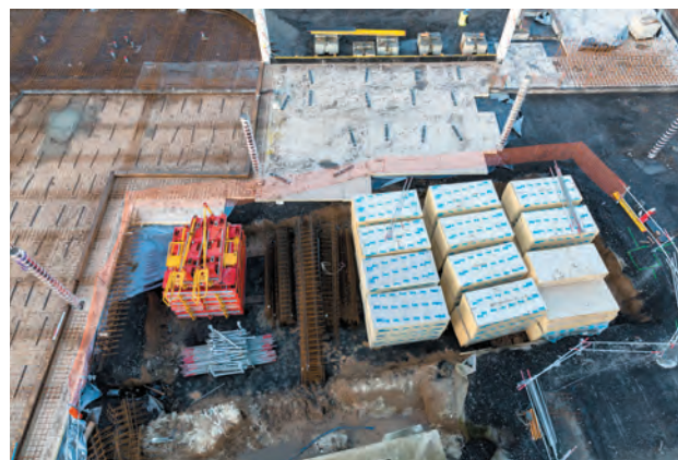
Stockage sur chantier des palettes de panneaux Knauf Thane Dallage
