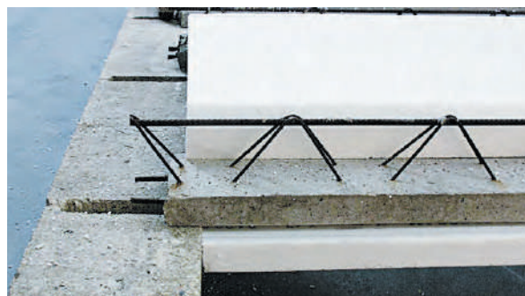
Fig. 2 : vue de la poutrelle sur l'entrevous
