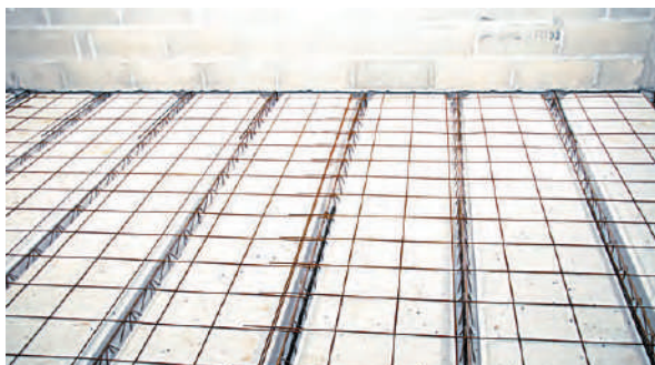
Pose de Knauf Treillis Therm Coffrant retourné
