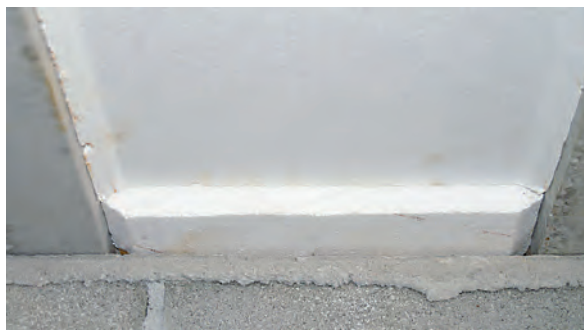
Pose de Knauf Treillis Therm Coffrant about
