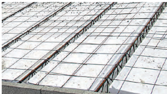
Pose de Knauf Treillis Therm Coffrant traditionnelle
