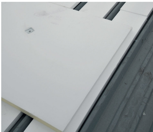
Procédé Knauf Therm Renovtoit BA2
