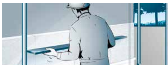
Fig. 6 : Contrôle de la planéité
