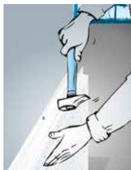
Fig. 9d : Fixation mécanique du profilé horizontal
