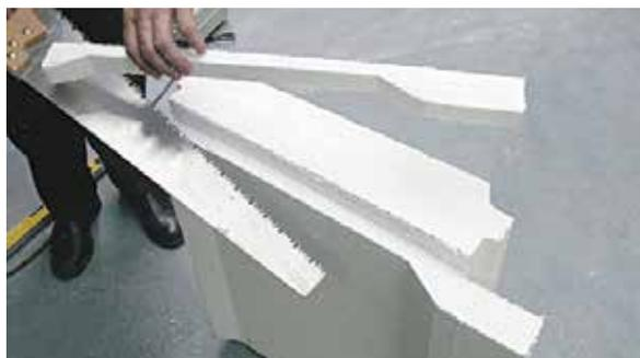
Fig. 1 : découpe de la feuillure d'appui de l'entrevous sur le mur
