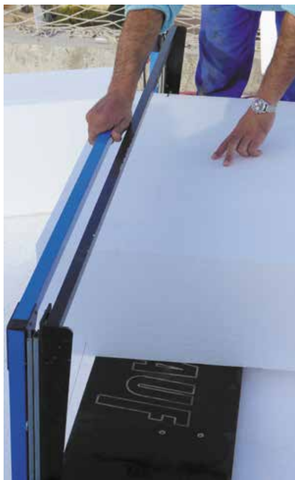
Découpe au fil chaud des panneaux isolants Knauf Therm TTI Se à l'aide de la machine Knauf Fusio Cut.
