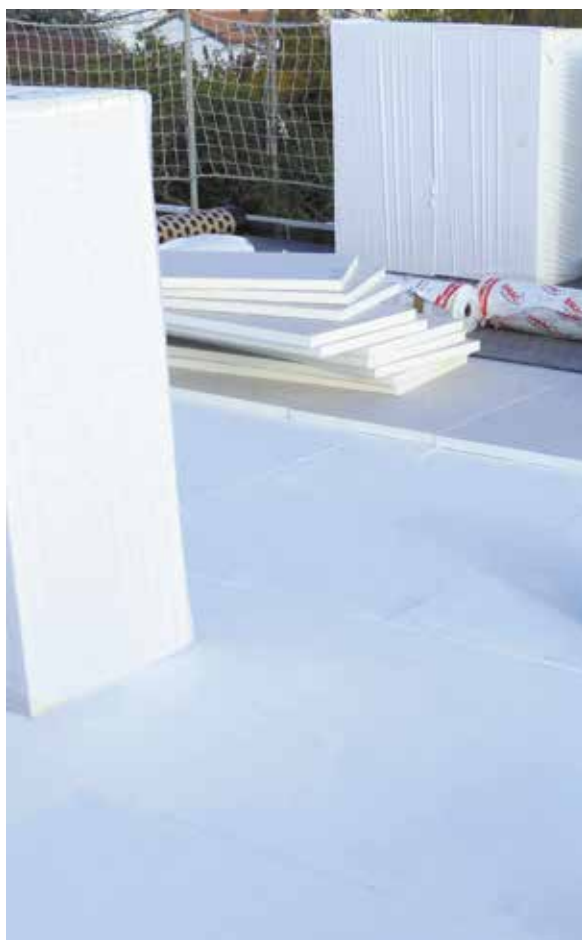
Sur le pare vapeur, pose libre du 1 er lit de panneaux isolants Knauf Therm TTI Se puis pose libre à joints décalés du 2 ème lit de panneaux isolants Knauf AsfalThane.
