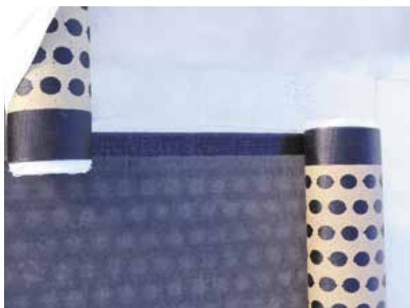
Pose de la feuille d'étanchéité spécifique du procédé d'asphalte mixte sur les panneaux isolants Knauf AsfalThane.
