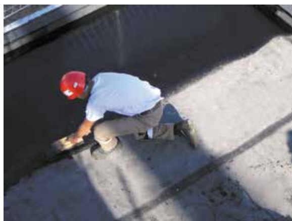
Application de l'asphalte chaud sur la feuille d'étanchéité.
