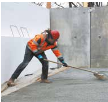
Préparation du lit de pose
