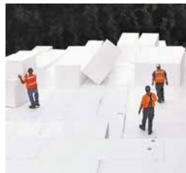
Montage du remblai Knauf Geofoam TP
