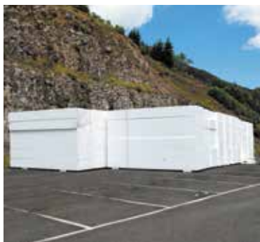
Stockage des blocs de Knauf Geofoam TP sur chantier
